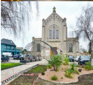
Patrimoine : l'église communale du Sacré Cœur refaite à neuf, et le parvis de Sainte-Germaine rénové.
